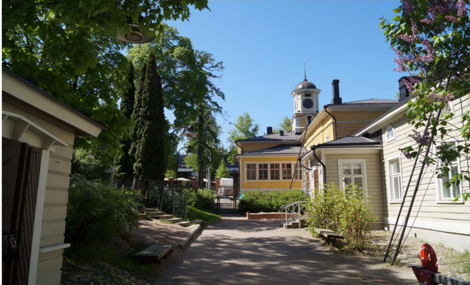
Näkymä raatihuoneen korttelin sisäpihalta, jossa raatihuoneen laajennuksen kohdalla on aiemmin toiminut lasten päivähoiton leikki-piha. (Lappeenrannan kaupunkisuunnittelu)
